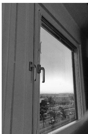
Bild 1. Nytt fönster med vädringslucka
